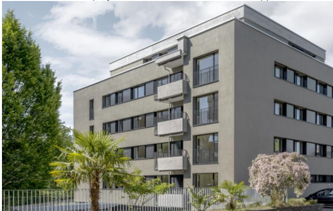
Repositionnement terminé au Zugerstrasse, 6312 Steinhausen (ZG)
