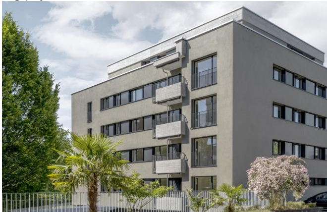
Fertiggestellte Repositionierung an der Zugerstr. in Steinhausen (ZG)
