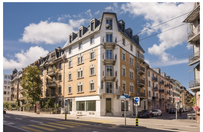
^ Durch das Aufstocken der städtischen Liegenschaft in Holzbauweise konnte zusätzlicher Wohnraum geschaffen werden.
